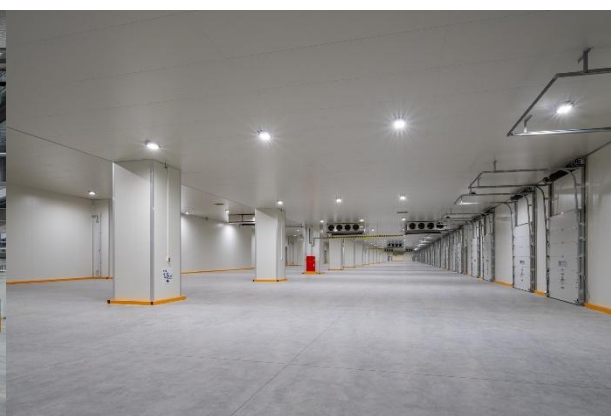
【冷凍冷蔵倉庫 (荷捌きエリア)】
